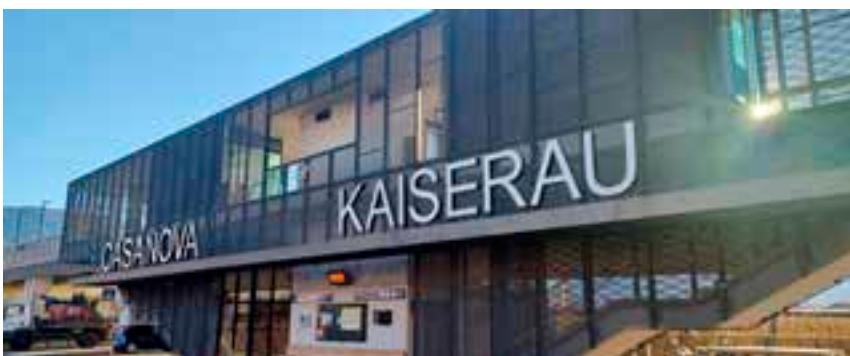
Der 2013 eröffnete Zugbahnhof Kaiserau
